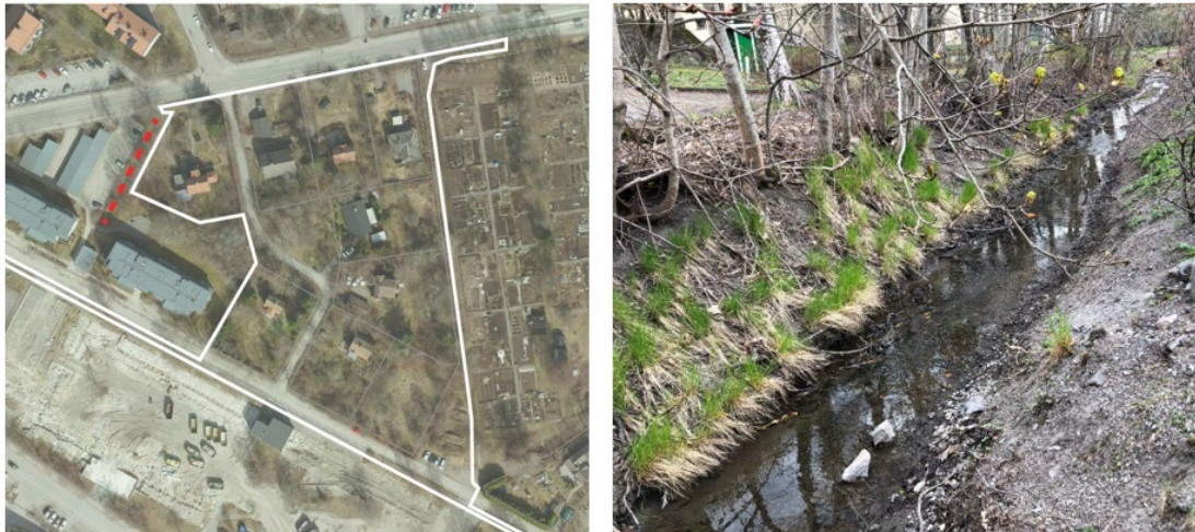
Figur 34. Väster om planområdet finns ett dike, markerat i rött. Planområdesgränsen ses markerad i vitt.
