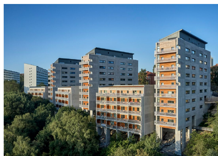
Exempel på bebyggelsemiljö i överensstämmelse med gestaltningprinciper för karaktärsområde 2. Brf Viva, Göteborg. Foto: Ulf Celandier. Arkitekt: Malmström Edström Arkitekter och Ingenjörer
