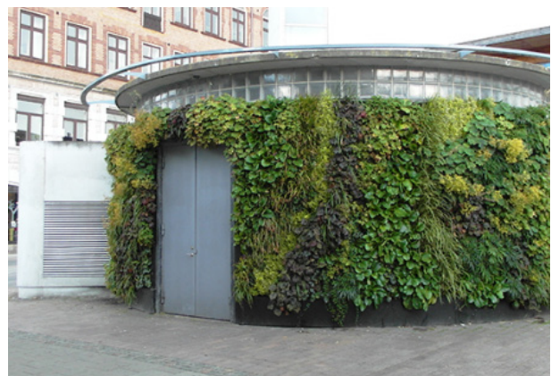
Exempel på fasadgrönska vid Karlbergs station. (Bild: wikipedia)
