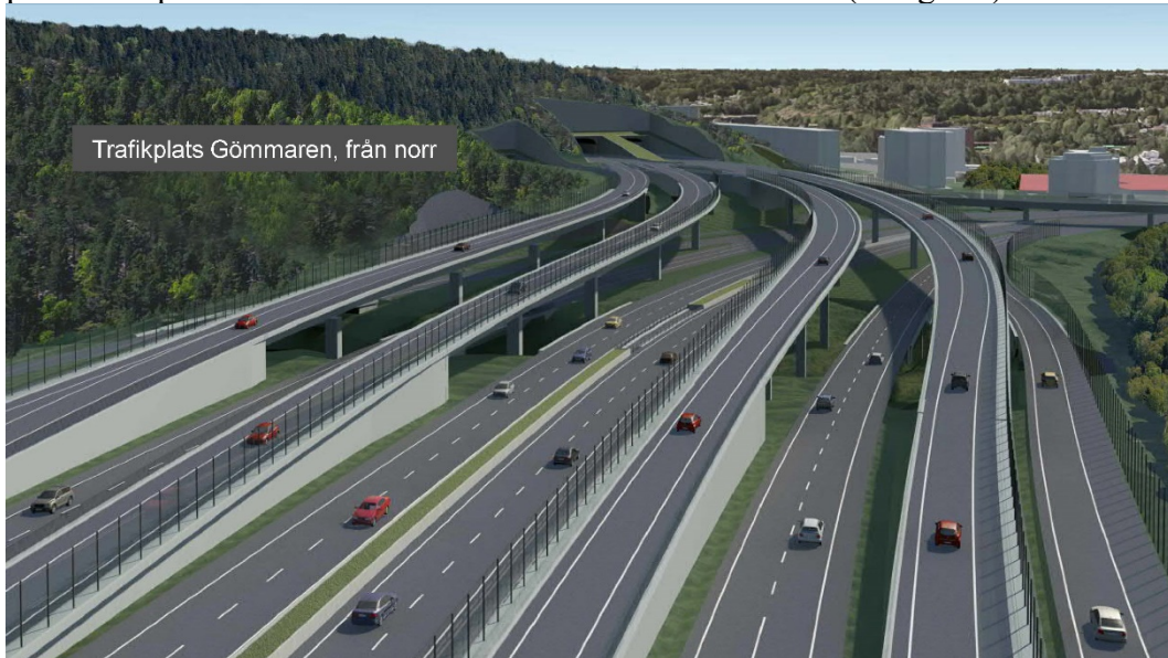
Figur 8: Skiss över Tvärförbindelse Södertörns med vy söder ut. Här redovisas kopplingen mellan E4/E20 och Tvärförbindelse Södertörn. Av- och påkörningsramper från E4/E20 svänger öster ut och in i Masmoberget. Rendering gjord av Trafikverket.
