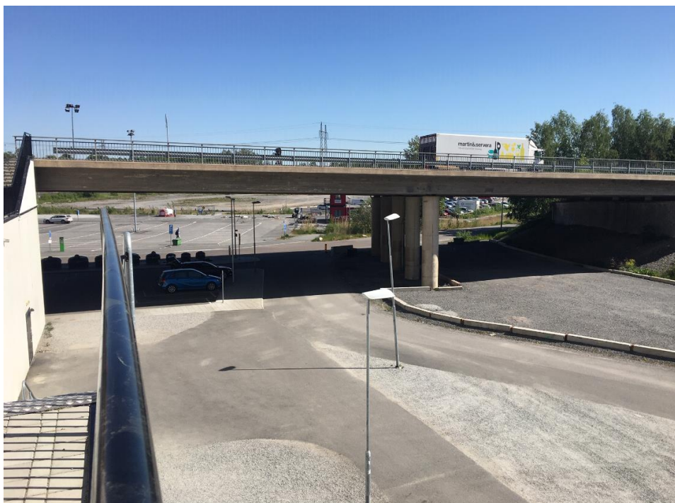
Befintlig infart till planområdet under Regulatorbron
