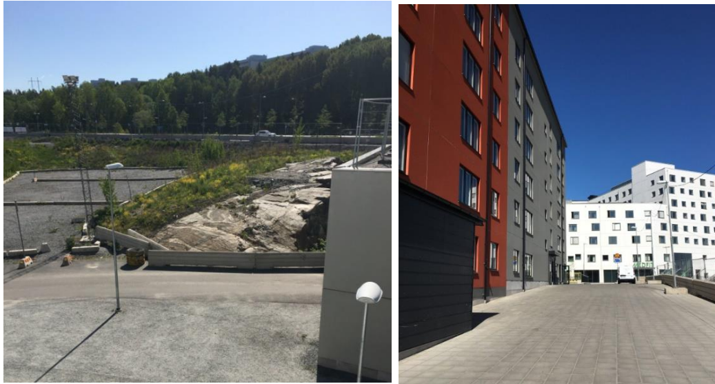
Delar av planområdet, fastigheten Generatorn 2 samt gränden mot Ebba Bååts torg
