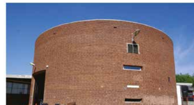
Foto av Panncentralen
