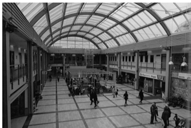
Bild som visar Skogås centrum inifrån. Skogås centrum byggdes först som fristående byggnader men fick sedan ett tak 1986. Sedan dess har centrumet varit ett inomhuscentrum och en omtyckt mötesplats. Källa: SKOGÅS - Från torp till förort av Solveig G Hägglund, s.134
