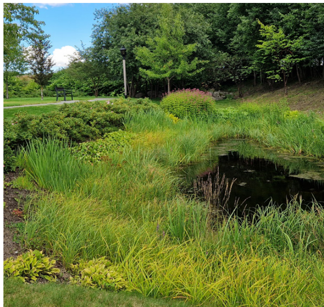
Dagvattendamm i parkmiljö i Botkyrka. Foto: Erik Sundin.
