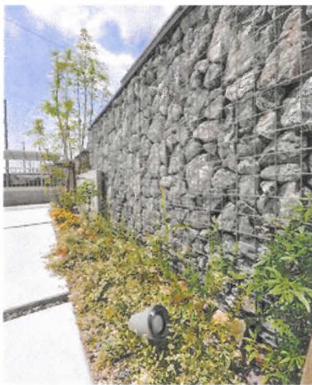
2. Exempel på gabionmur.
