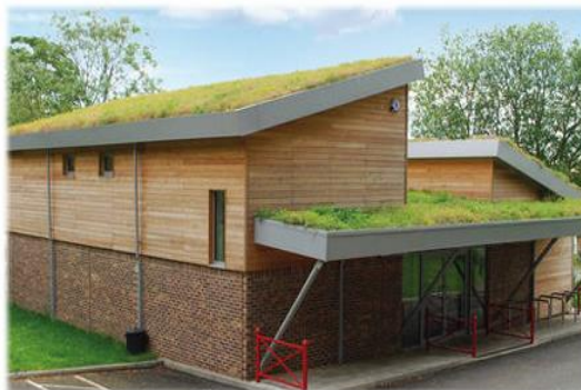
Figur 7. Gröna tak. Taken kan anläggas på både platta och lutande underlag (Svenska Naturtak, 2016)
