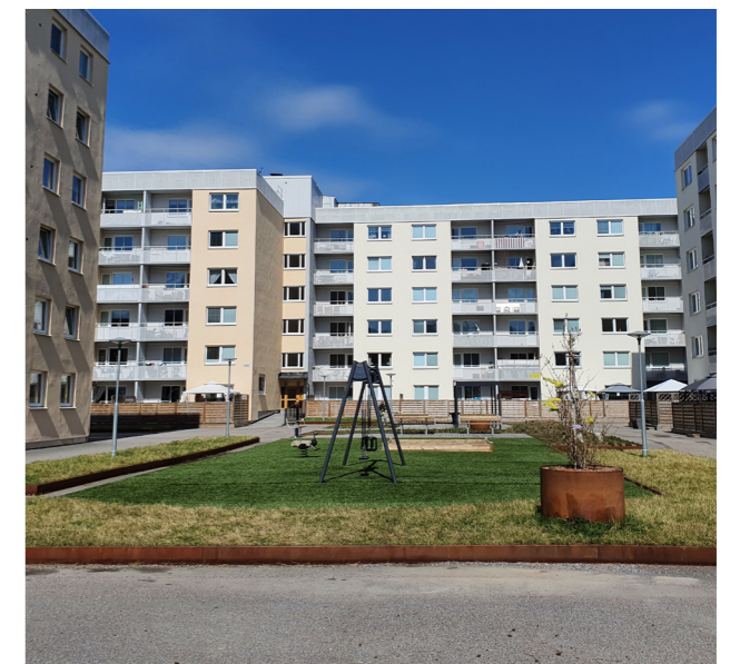
Bebyggelse vid Visättravägen. Foto: Lin Normark
