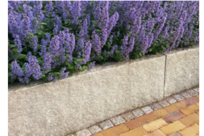
Stödmurar av granitblock som tar upp nivåskillnaderna..
