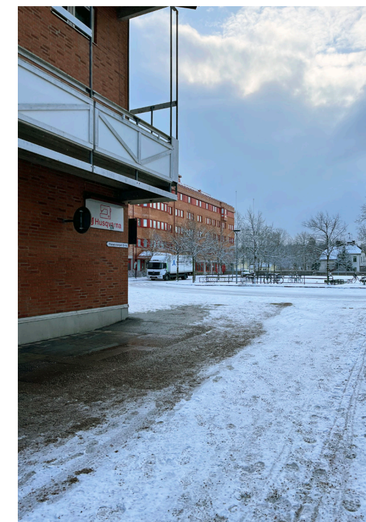
Vy mot blivande kommunhuset
