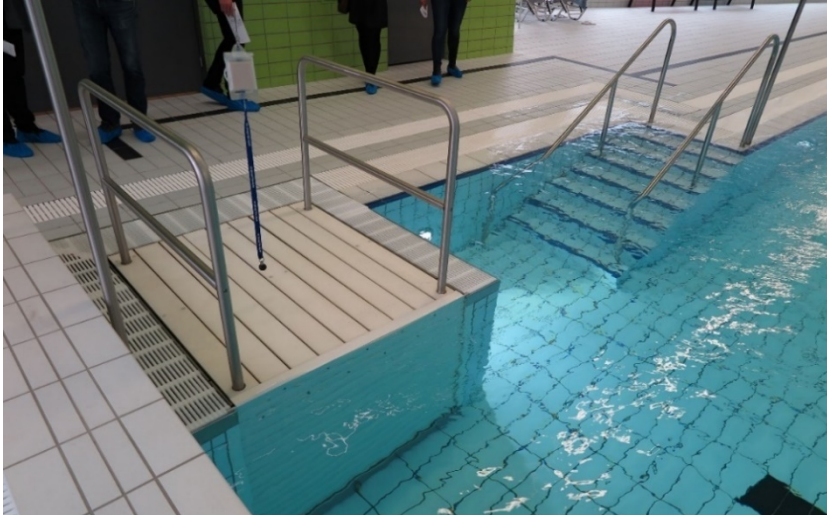
Bild 4 Bilden visar lyftplan. Fungerar som hiss för personer som använder rullstol och som de själva kan sköta upp och nedfarten ur vattnet.
