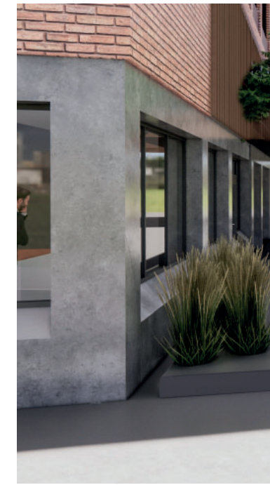
Befintligt fasadtegel plockas ned och återbrukas, sockelvåning i betong behålls i originalutförande
