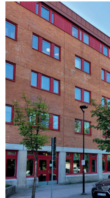
Paradisbacken 33 i befintligt skick
