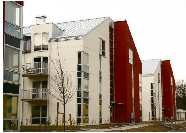
I Jonsered i Göteborg 59 energieffektiva lägenheter där det årliga beräknade energibehovet uppgår till 40 kWh/kvm. Energiförbrukningen i fastigheterna är koldioxidneutralt tack vare energismart teknik och att övrigt värmebehov täcks av Wallenstams egen vind- och vattenproducerade el. Samtliga lägenheter har individuell mätning av både el och vatten. Varje hus har 14 till 15 lägenheter fördelat på fyra våningsplan.
