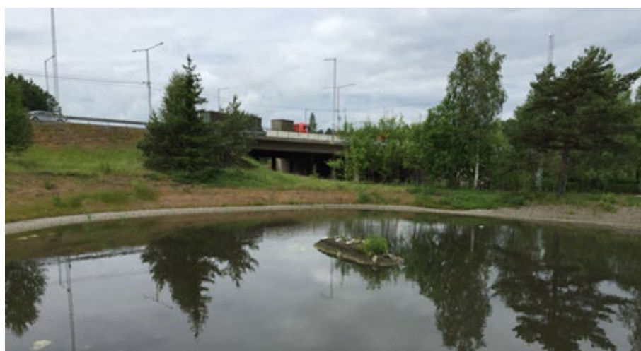
Gudöbrodammarna fördröjer och renar dagvatten från bland annat den hårt trafikerade Gudöbroleden i Haninge. Foto: Hillevi Virgin.
