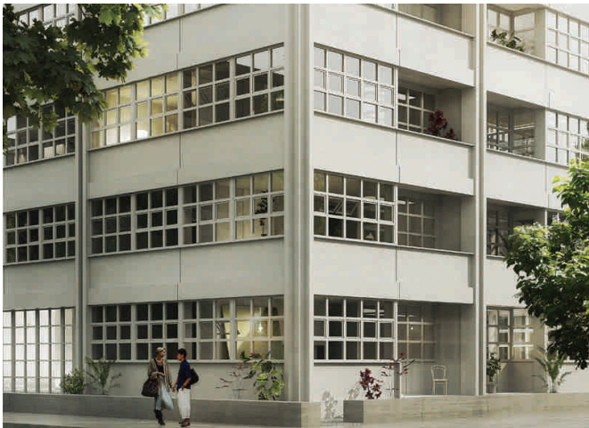
Referens industrikaraktär med markerad sockel i betong (HG7, Andreas Martin Löf Arkitekter).
