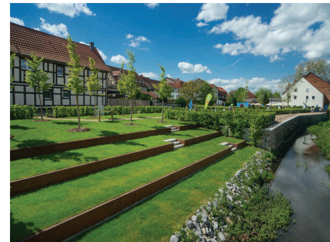
Gradänger gestaltar Gömmarbäckens stränder intill skolan och fungerar som översvämningsszon vid kraftiga flöden i bäcken.
