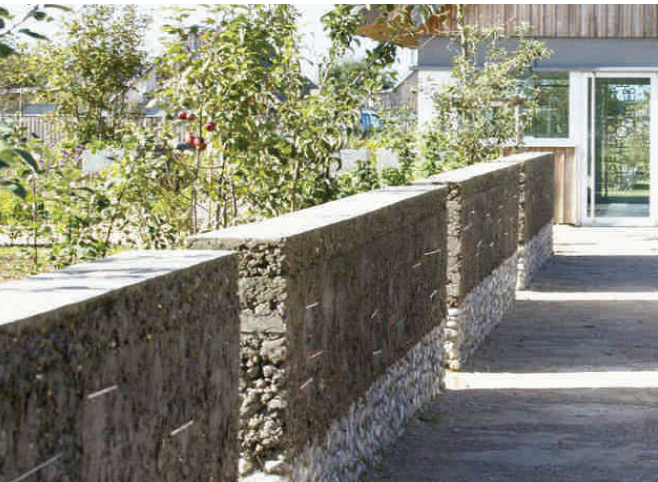
Barriärmurar av gabioner som fylls med sten eller tegelkross från platsen skapar en direkt koppling till det historiska.
