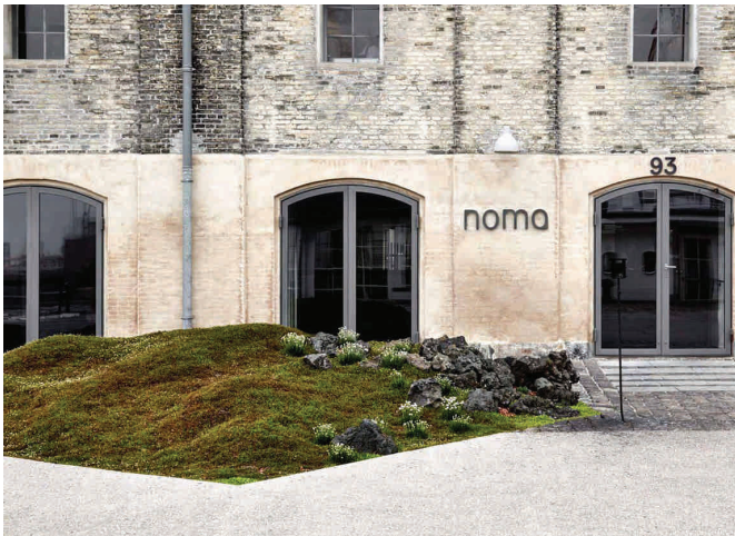
Referens, gammal magasinsbyggnad i Köpenhamn, industrikaraktär (Noma, Polyform).
