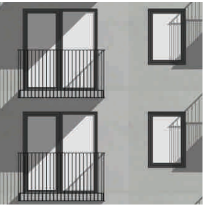
Betongfasad med pinnräcke och fönster till golv.
