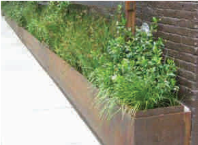
Takvatten fördröjs via en smal men lång och sammanhängande förgårdsmark.
