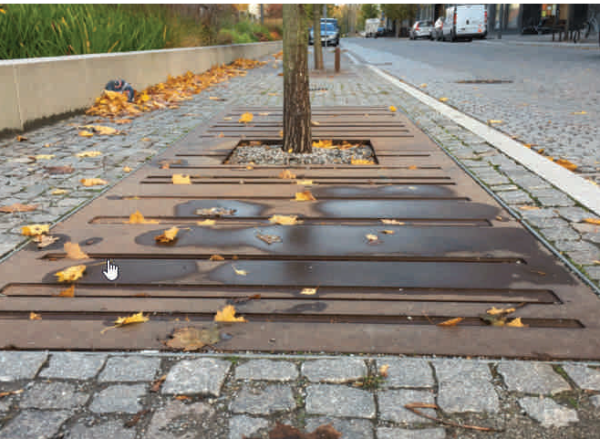
Skelettjordar fördröjer stora volymer vatten och erbjuder samtidigt utmärkta förutsättningar för träd i gatumiljö.
