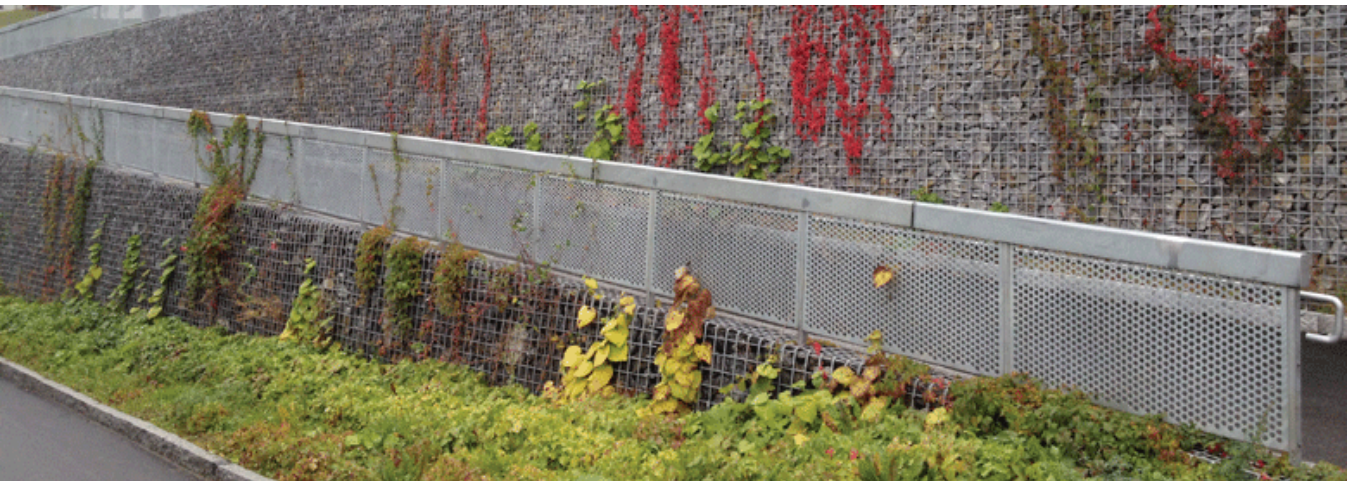
Trappor och ramper inom skolgården utgörs av gabionmurar med växtlighet. Referens Sjövikshöjden, Årstaberg.
