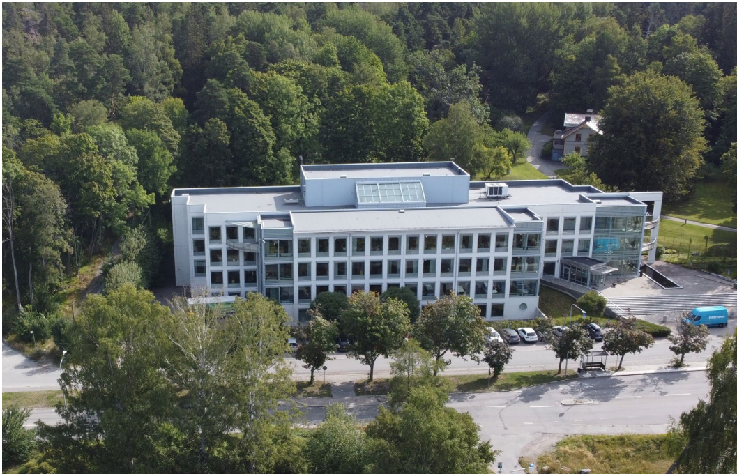
Figur 80. Foto över kontorsbyggnad (Spendrups tidigare huvudkontor) som föreslås omvandlas till skolbyggnad.
