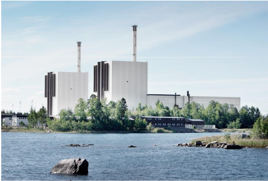
Forsmarks kärnkraftverk, Uppsala län, ligger cirka 12 mil från Stockholms centrum. Foto: Vattenfall.
