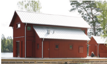
Falsat plåttak/ pannplåt
