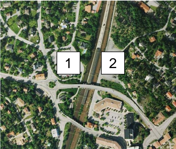
Figur 6: Anläggningar för infartsparkering i Stuvsta Huddinge (198 parkeringsplatser)
