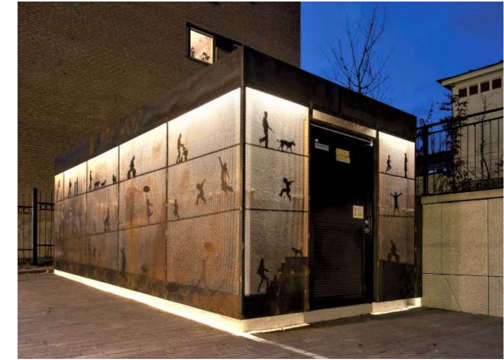
Referensbild som visar väl gestaltad teknisk anläggning. Stationsgatan Uppsala
