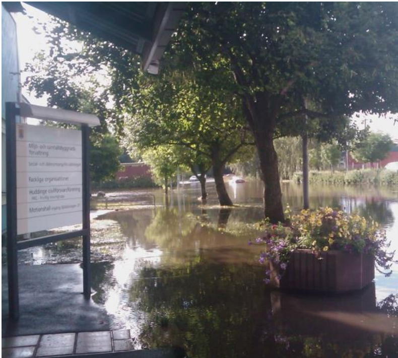
Figur 10. Översvämning på Södalsvägen utanför Tekniska nämndhuset i nordöstra Storängen (utanför planområdet) 23 .
