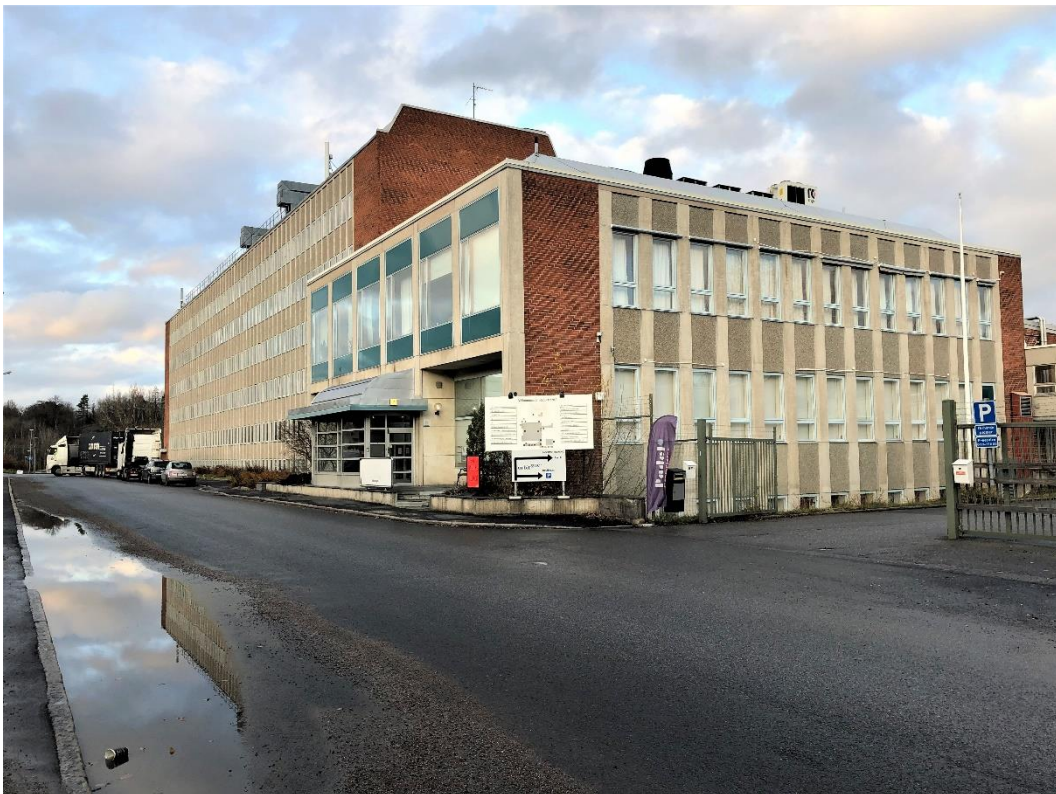
Kontorsbyggnaden på fastighet Regulatorn 1 bedöms vara av kulturhistoriskt värde.
