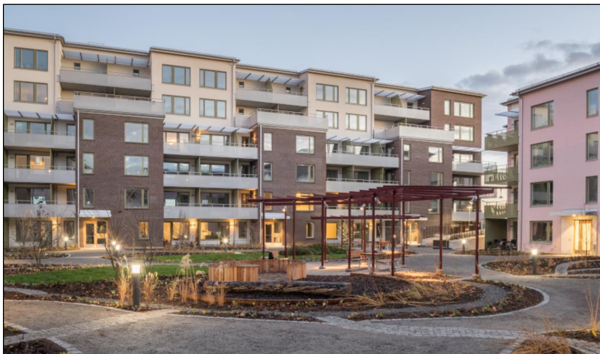
Figur 6-5. Exempel på gestaltning av innergård med avledning av dagvatten via öppna rännदार till planteringsytor och grusade infiltrationsstråk. Källa: Uppsalahem, Områdesbilder Linnéhuset.
