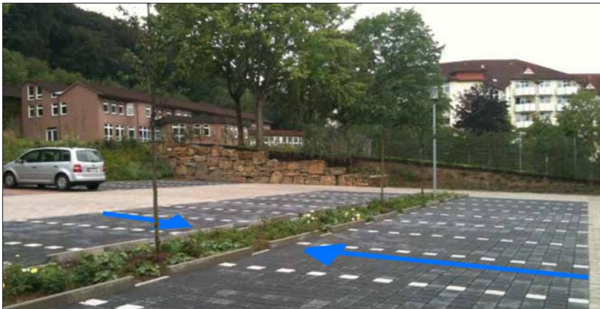
Figur 6-12. Exempel på utformning av dagvattenhantering inom parkeringsytor. Mellan parkeringsremsoarna anläggs ett vegetationsstråk där vattnet kan infiltrera. För ytterligare förbättrad effekt och reducerat volymbehov föreslås parkeringsytorna anläggas med genomsläpplig beläggning.
