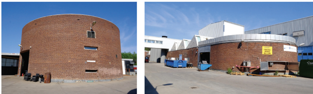
Foton av befintliga byggnader, panncentralen TV, "Cigarren" TH.
