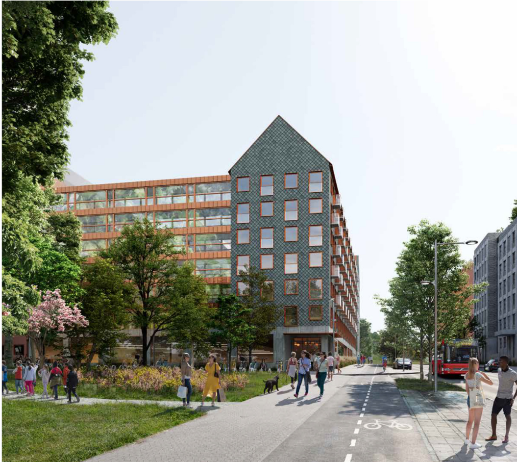
Kvarter F2 vid Vårby allé med planerad idrottshalls entré i fonden, sett från parken i norr. Volymen binds samman av skärmar (Visionsbild, Arkitema).
