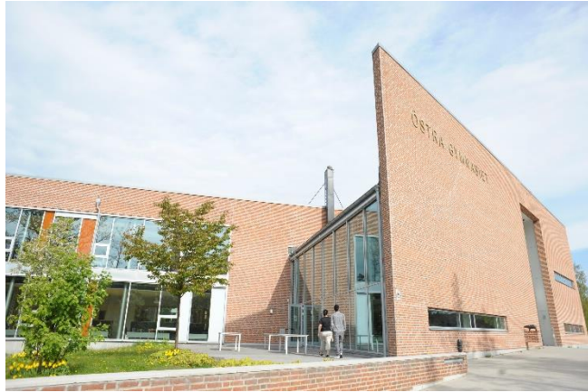
Figur 19 och 20: Fasad och interiör, Östra gymnasiet
