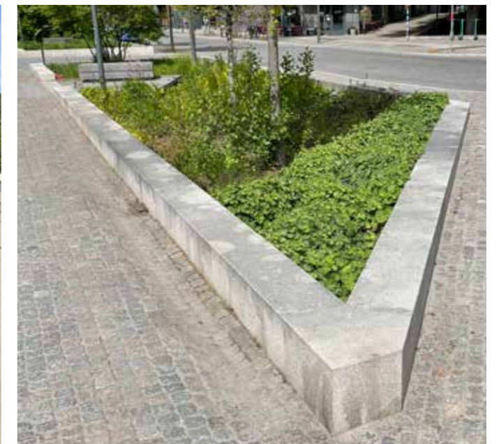
Växtbädd omgärdad av natursten, Norra Djurgårdsstaden.
