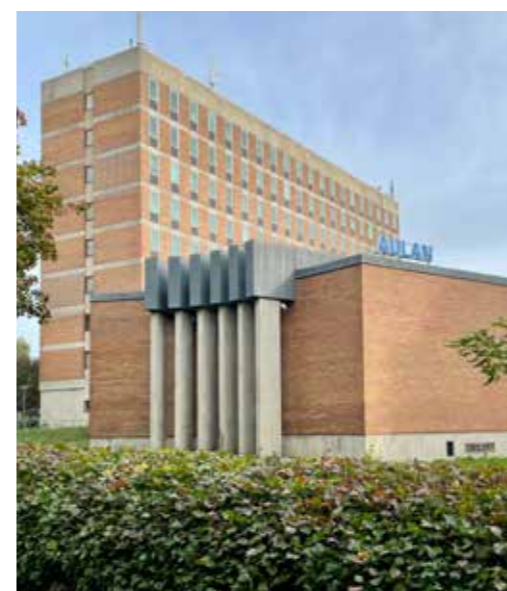
Aulans baksida i förgrunden, i tegel med vertikala betongelement. Kontorshuset i bakgrunden, även denna i tegel och med tydliga och typiska fönsterband. Sett från gång- och cykelvägen utmed Lännavägen
