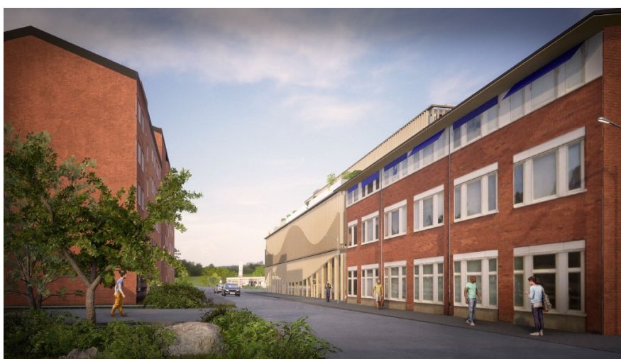
Vy mot Kommunalvägen, Paradisgaraget. Bild: Liljewall Arkitekter
