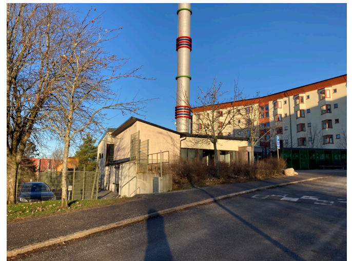
Byggnaden är uppförd i suterräng. Stödmurar bidrar till att jämna ut marken. I väster angränsar ett promenad stråk.
