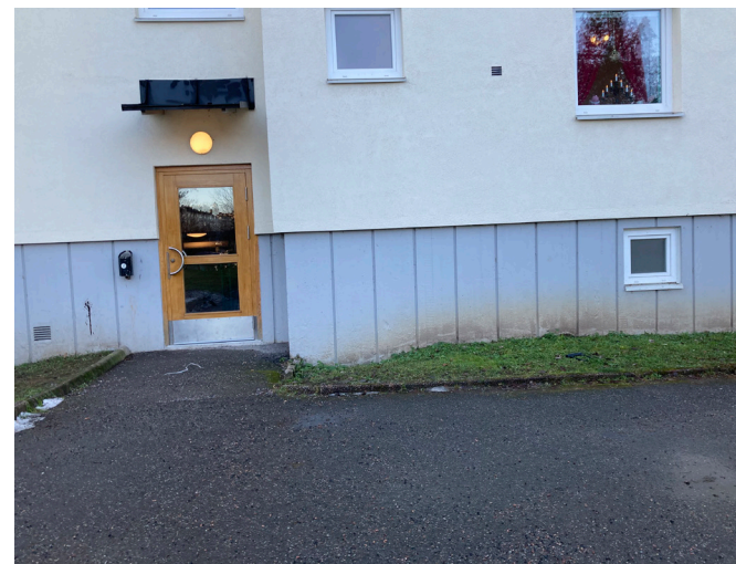
Indragen fasadparti med entrédörr på det västligaste friliggande flerbostadshuset. Sockeln har vertikala spår. Äldre bevarad förgård som ramas in med tidstypisk kantsten.
