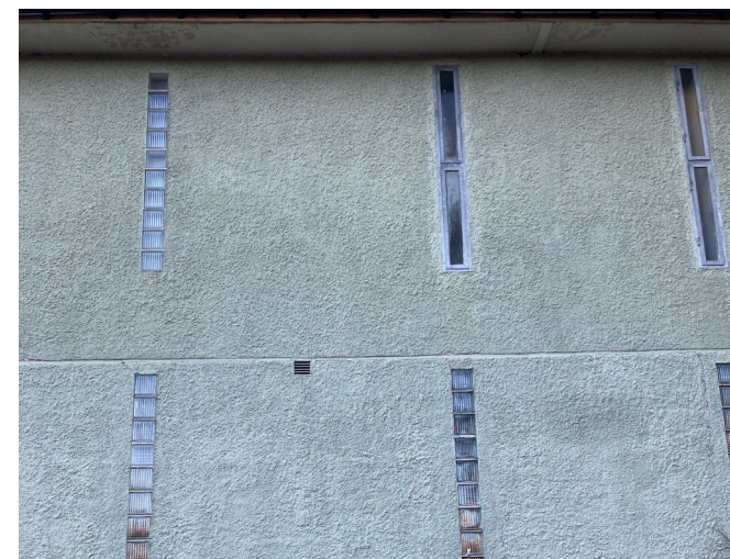
Långsmala fönster med betongglas. Fasaden är grovputsad
