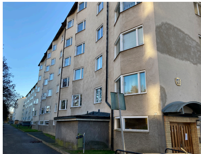
Mot söder skapar burspråken en veckad fasad vilket möjliggör gott ljus insläpp. Till vänster syns port med omfattning i gult tegel och portdörr i trä.
