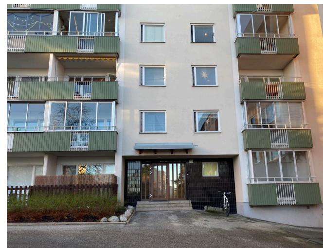
Diskreta indragna entréer som omges av omfattning i natursten. Till vänster syns ursp. belysning. Portdörrar är sentida.
