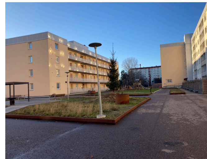
Parallellt ställd bebyggelse. De norra bostadshusen är sammanbyggda på rad men något förskjutna vilket skapar mer vinklar i gårdsmiljön.
