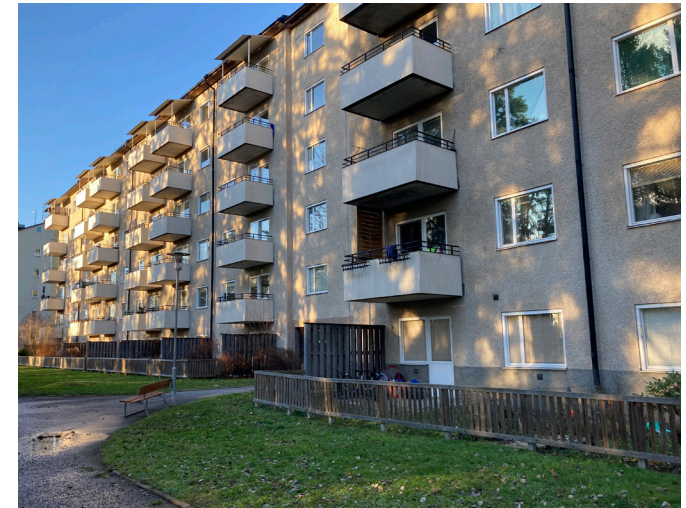
Den södra fasaden med balkonger. Fasaden har en regelbunden uppbyggnad, präglad av repetitionens estetik.
