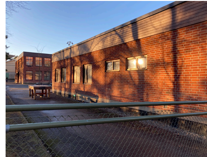
Södra sidan. Skolbyggnaderna har flera olika typer av fönster.
