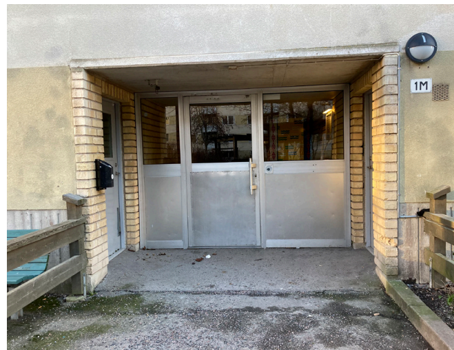
Diskreta indragna entréer med väggar i tegel. De putsade fasaderna möter en sockel med strukturmönster.
