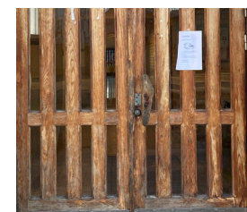
Trä som detaljmaterial
