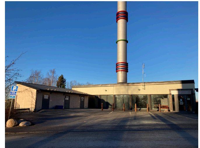
Den tidigare panncentralen möts av en plan asfalterad yta. I dess västra del finns en mindre tillbyggnad.
