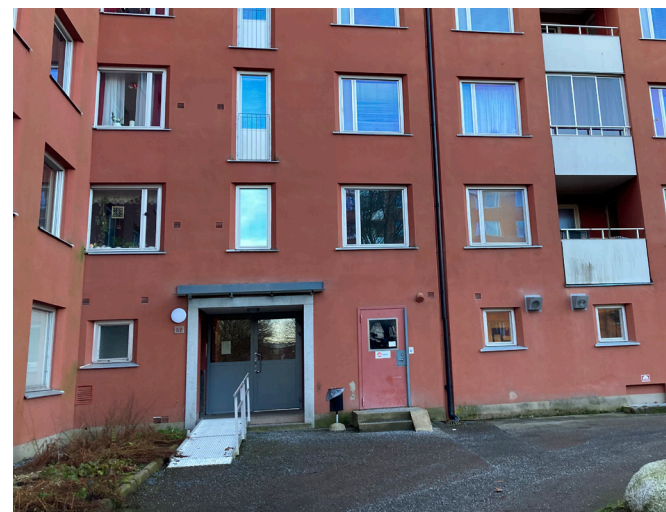
Diskreta indragna entréer som omges av omfattning i natursten. Till vänster syns ursp. belysning. Portdörrar är sentida.
