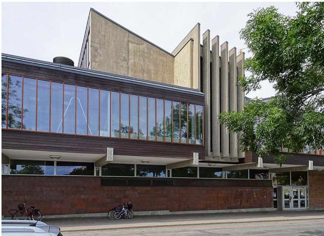
Högdalshallen byggd 1971, arkitekt Åke E Lindqvist. Foto Holger Ellgaard.
