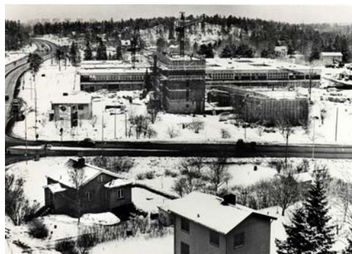
Foto från byggtiden. Foto från mapio.net.
