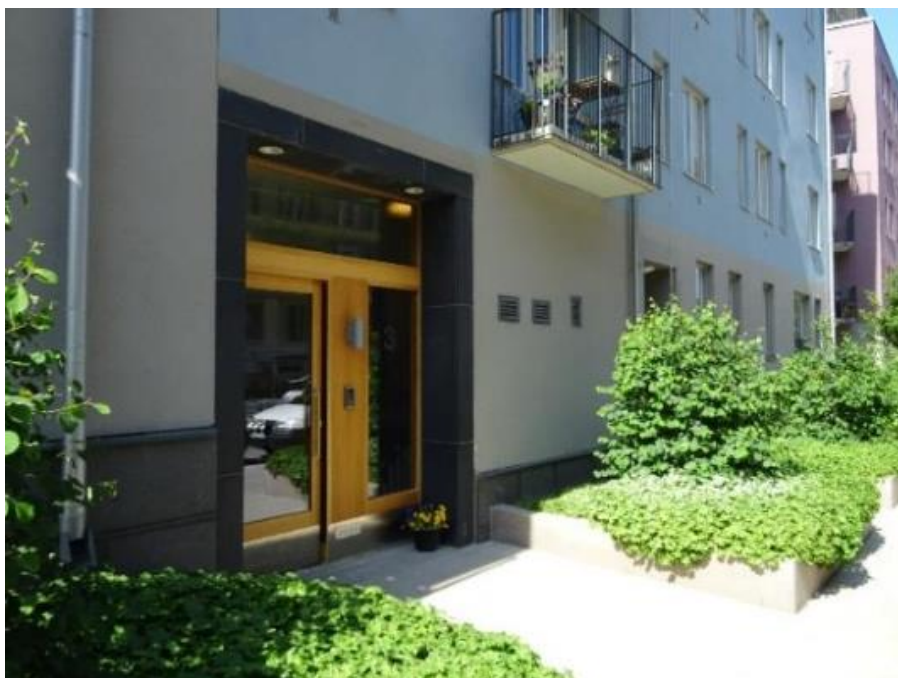
Figur 30. Exempel på regnbäddar för takvatten placerade på förgårdsmark i Stockholm. Foto: WRS.
