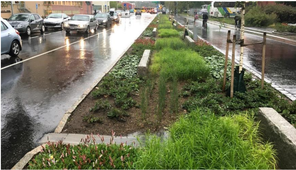
Figur 36. Exempelbild på ett stråk med nedsänkta regnbädd längs en gata (Strandbodgatan, Uppsala). Foto: WRS.
