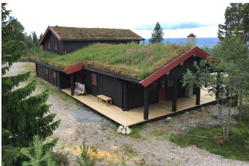
Figur 29. Exempel på utformning av tjockt grönt tak. Foto: WRS.
