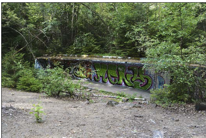
Fig 5. En markeringsgrav av betong till en skjutbana (objekt 14).
