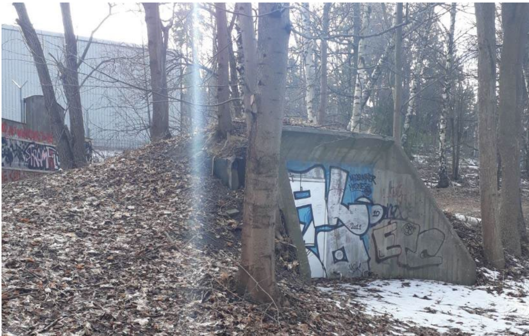
Figur 10, Foto från platsbesök 23.3.2018 som visar en betongkonstruktion vid den norra stranden. Foto: Arkitema
