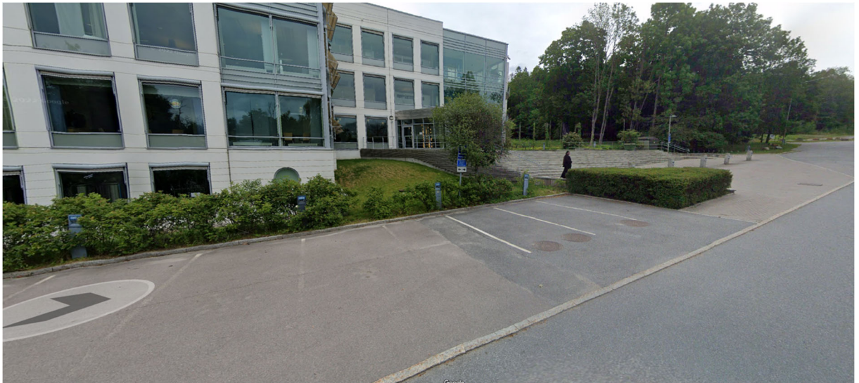
Figur 6. Byggnadens västra sida.
