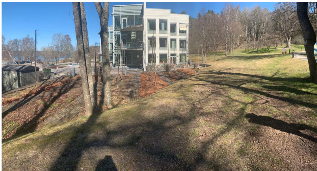
Figur 4. Planteringar och hårdgjorda ytor söder om kontorsbyggnaden.
