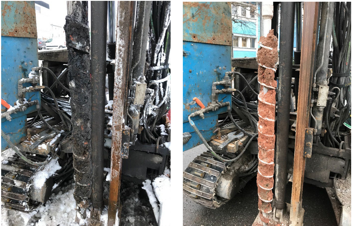
Figur 7-1 Två exempel på skruvborrar, punkt W67(vänster) med en mörkare karaktär på fyllning och punkt W58(höger) med fyllning med tegelkaraktär.
