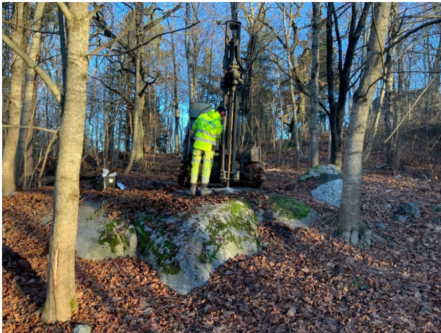
Figur 7-3 Bild över punkt BW001 provtagning med borrhandsvagn.
