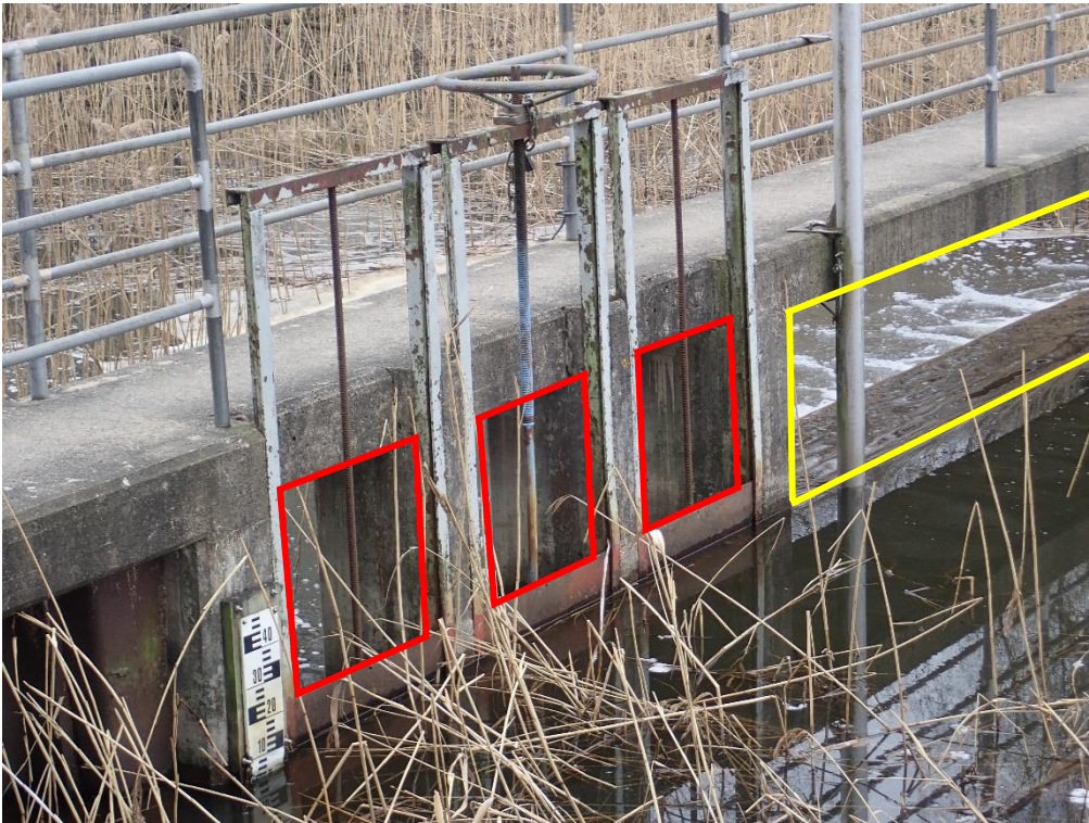
Figur 9. Befintligt dämme efter sjön Trehörningen. Röda linjer markerar öppning ovan reglerbara luckor, medan gul linje markerar del av överfall. Källa: Utlopps-dämme för sjön Trehörningen Förslag på ny lösning ARBETSVERSION (Ekologigruppen, 2018-07-06).
