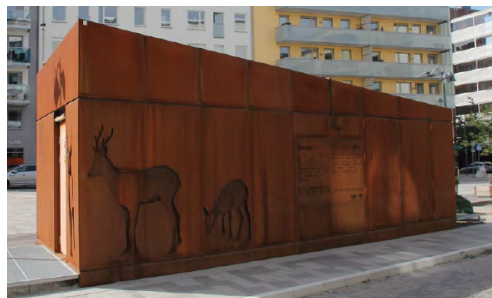
Omsorgsfullt gestaltad teknisk anläggning.
