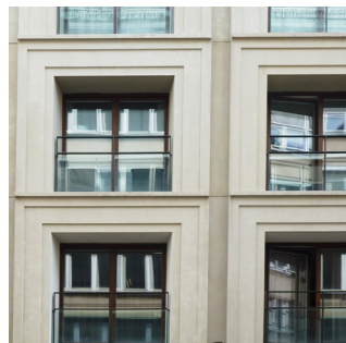
Skarvar mellan fasadelement dolda med en relief.
