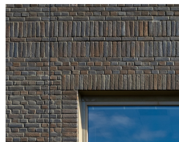
Exempelbild, detaljer i fasad
