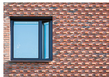
Exempelbild, detaljer i fasad
