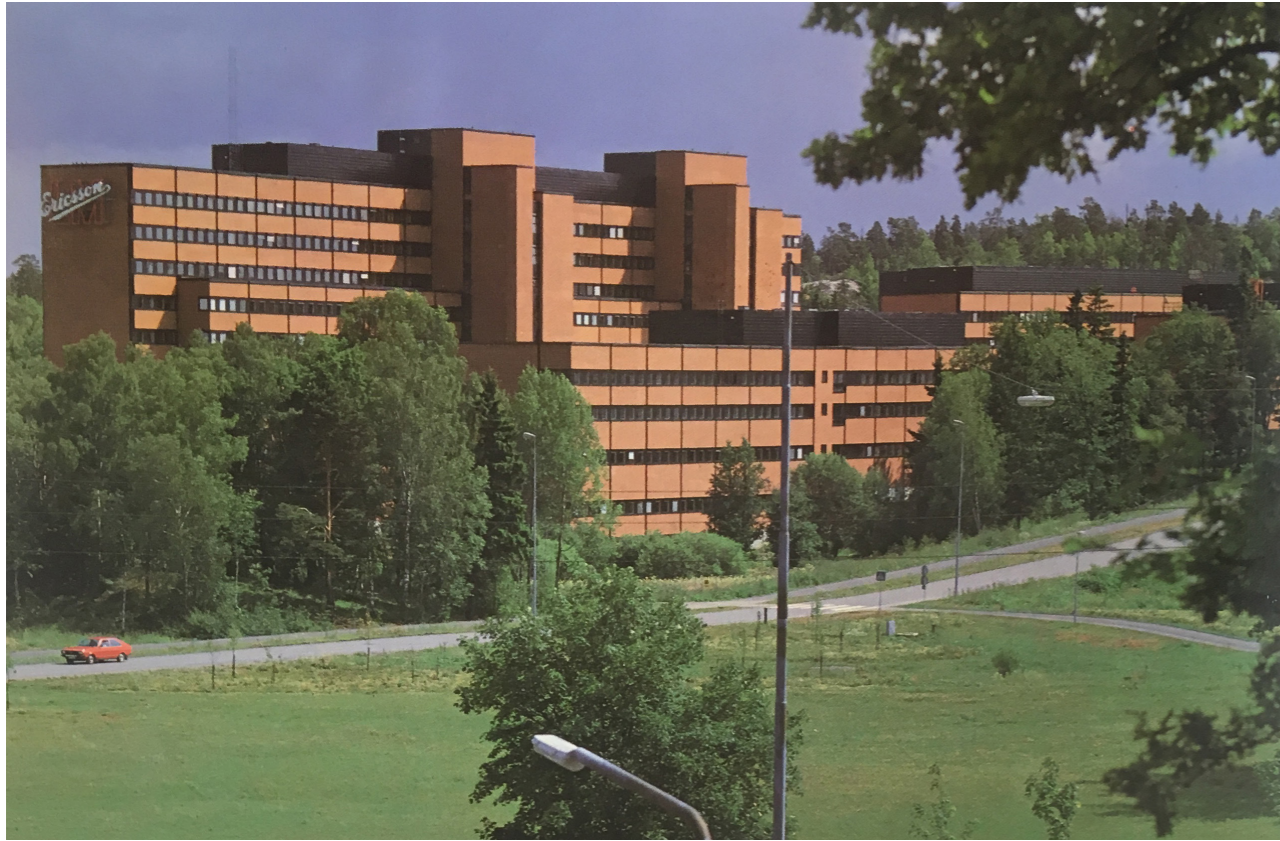
Foto över LM Ericssons nya anläggning i Kungens kurva. Ur LM Ericsson, Berg Arkitektkontor, Trycksak, KB.
