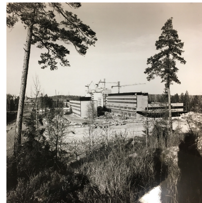
LM Ericssons nya kontor under uppförande. Foto: Centrum för Näringslivshistoria
