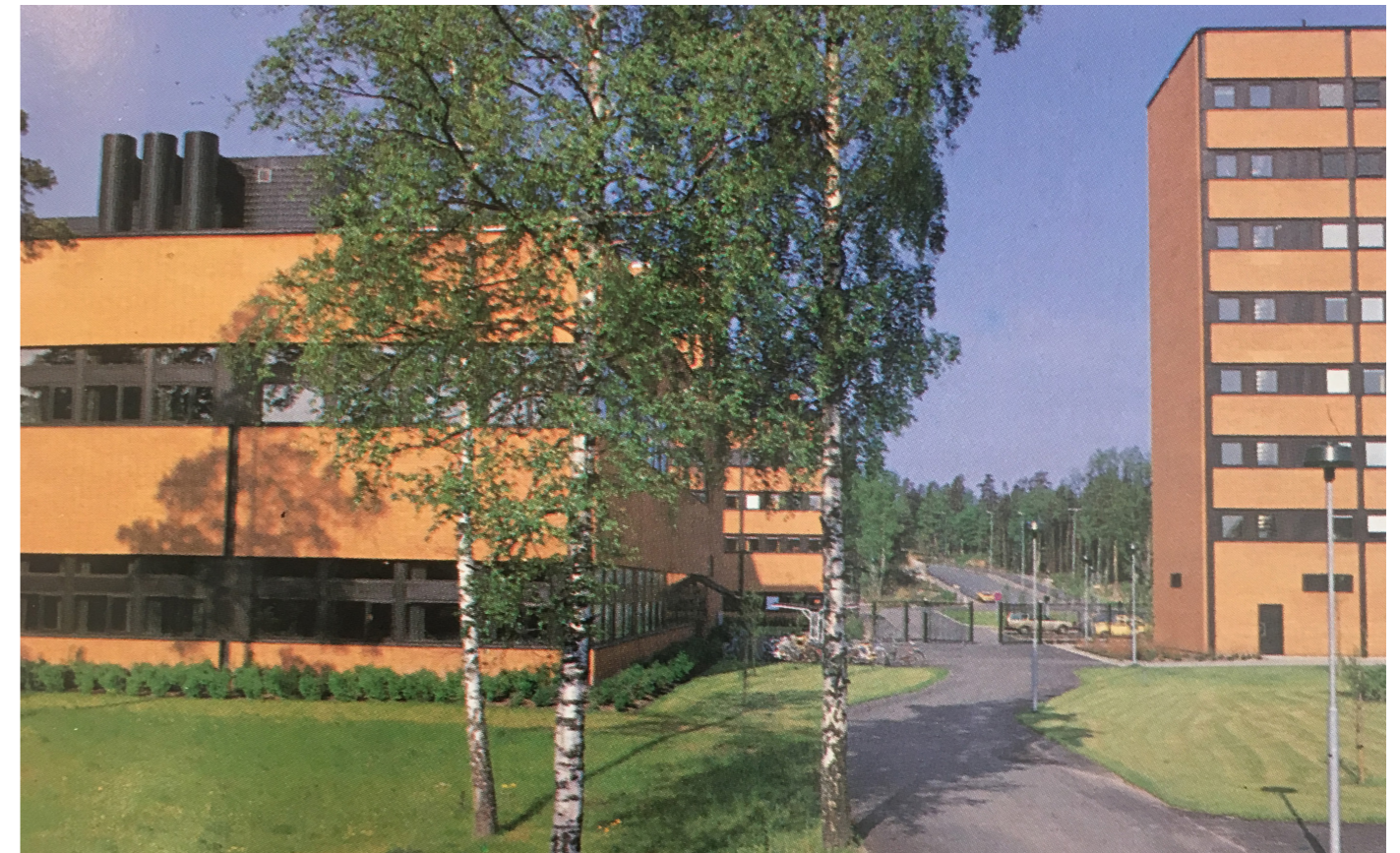
Foto över LM Ericssons nya anläggning i Kungens kurva. Ur LM Ericsson, Berg Arkitektkontor, Trycksak, KB.
