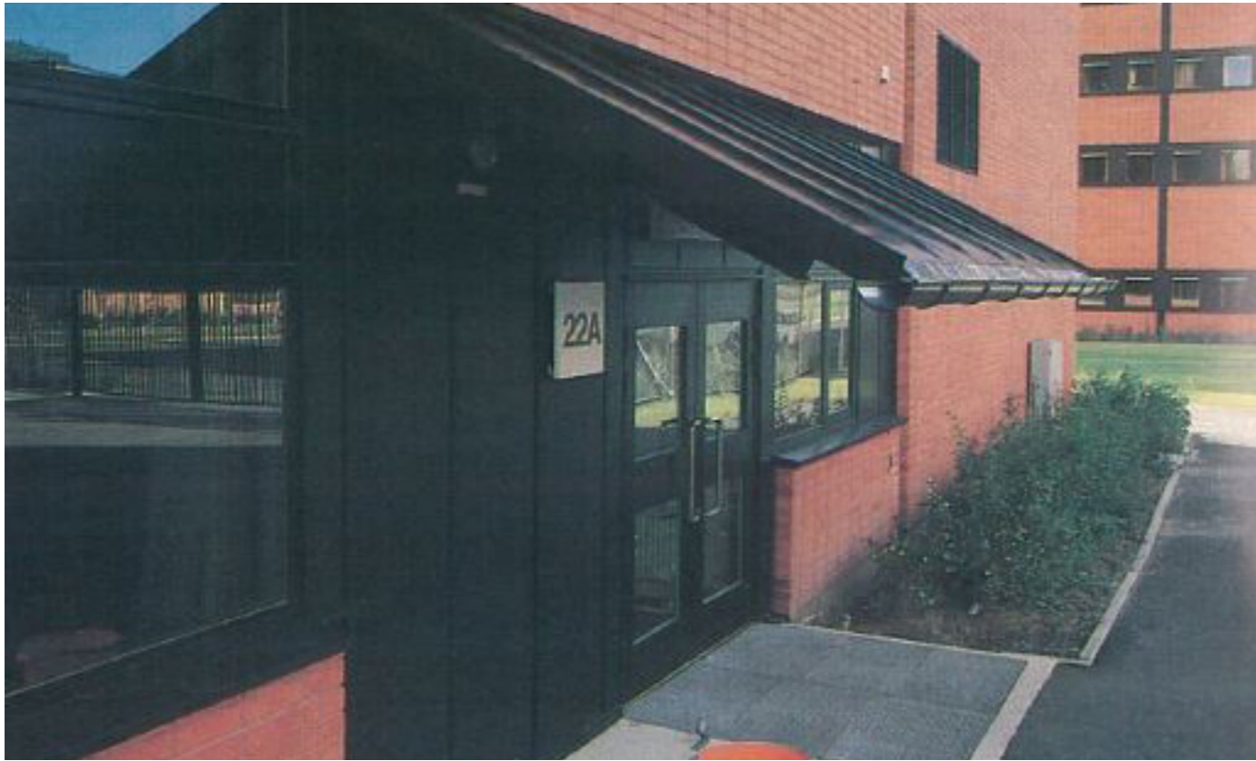
Foto över entréparti med dörrar och skärmtak av aluminium. Foto ur tidskriften Tegel.
