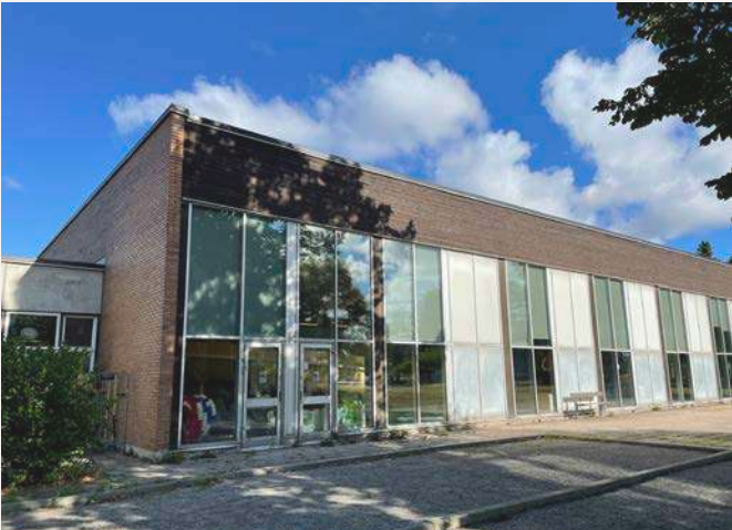
1. Befintlig simhall i tegel, trä och betong.
