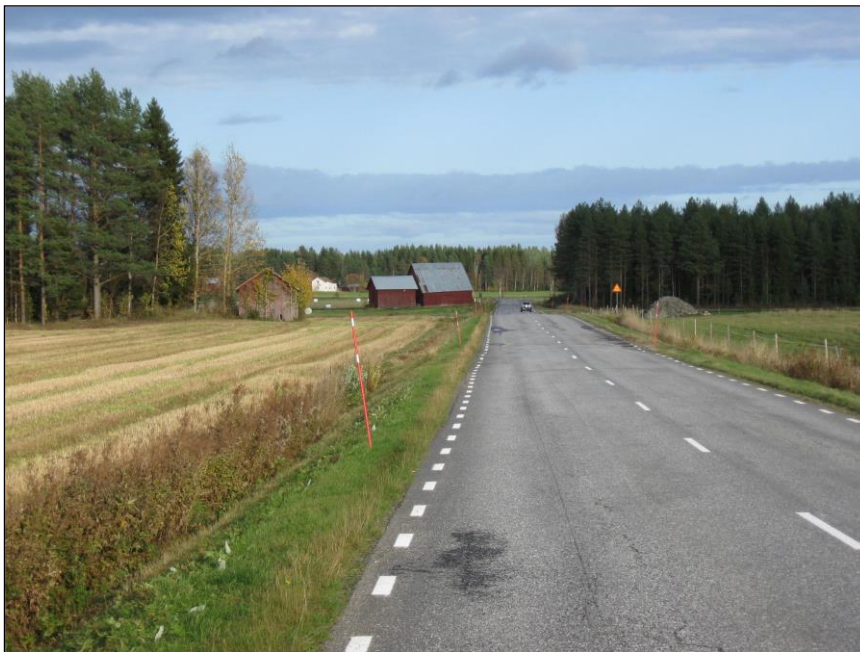
Figur 14. Exempel på vägdike, foto: Trafikverket
