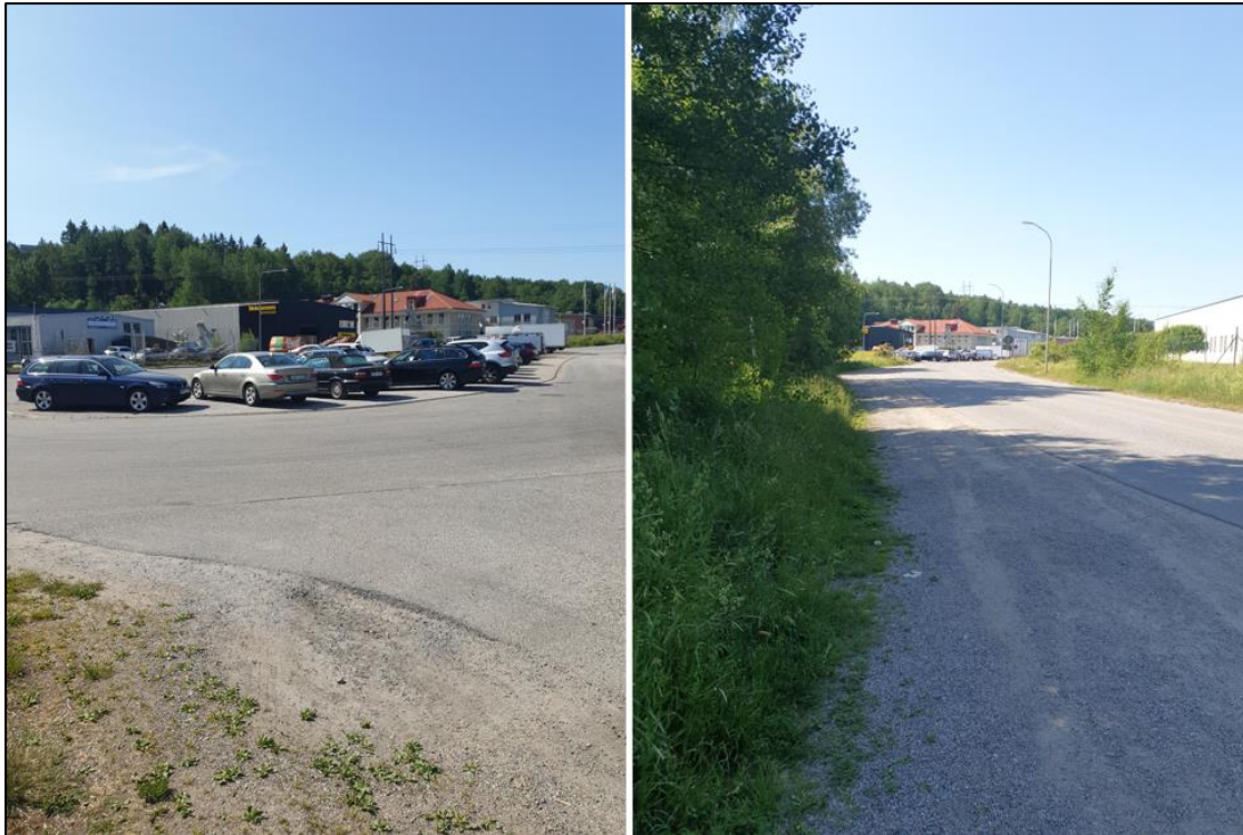
Figur 10. Parkeringsplats i utredningsområdets södra del samt Regulatorvägen
