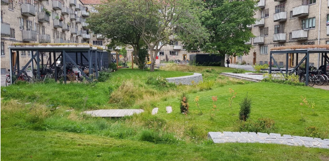
Figur 32 Exempel på innergården samt cykelparkering med gröna tak i Köpenhamn. (Bildkälla: Joakim Scharp)
