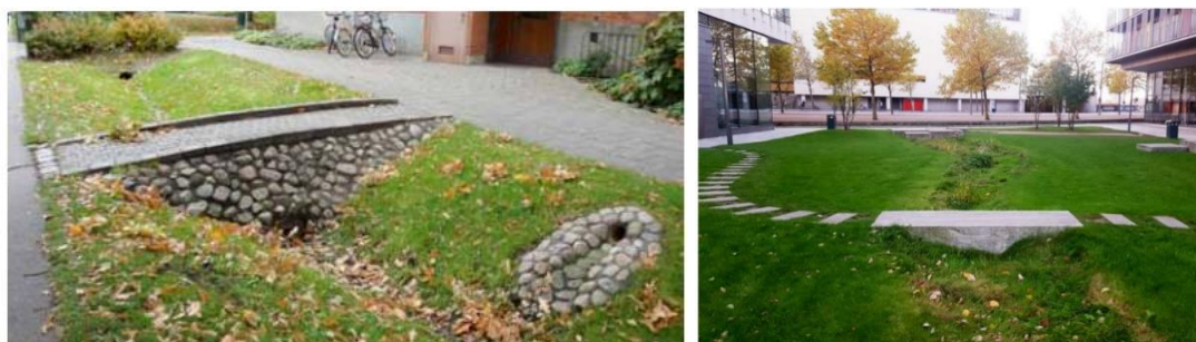
Figur 34 T.v. Svackdike med grusfyllning i botten, Augustenborg (Foto: Dagvattengruppen Sweco) T.h Svackdike Mariastaden, Helsingborg (Foto: Ramboll)
