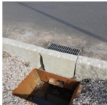
Figur 31. Regnbädd i Vellinge. GC-banan avleds via ytavrinning på "bred front" till bädden. Gatudagvatten leds till via en inloppsbrunn som är ansluten till ett sandfångskar. (Foto: Ramboll)
