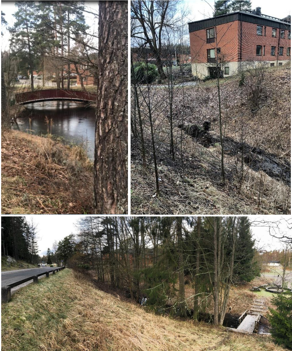
Figur 14. Foton från platsbesök 2020-02-20. Ovan till höger: Dammen sett från öst. Ovan till höger: Utlopp från dammen i öst till diket. Nedan: Dikets sträckning längs med del av Björnkullaringen som ansluter till Björnkullavägen.
