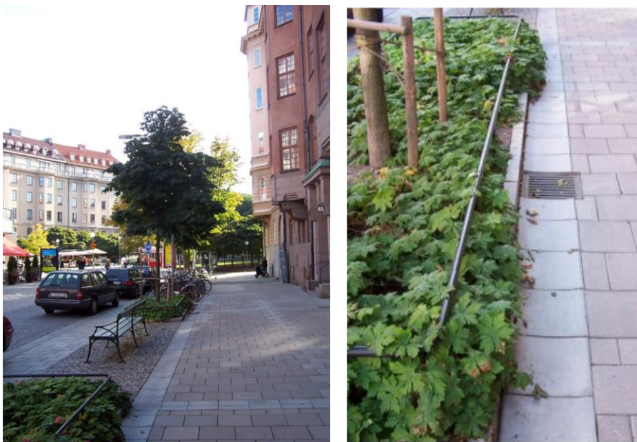
Figur 27: T. v.: Träd planterade i skelettjord längs gata. T. h.: Dagvatten kan ledas till skelettjorden via vanliga rännstensbrunnar. (Bildkälla och foto: Stockholm Vatten och Avfall)
