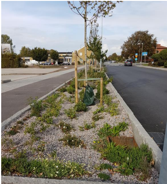
Figur 31. Regnbädd i Vellinge. GC-banan avleds via ytavrinning på "bred front" till bädden. Gatudagvatten leds till via en inloppsbrunn som är ansluten till ett sandfångskar. (Foto: Ramboll)
