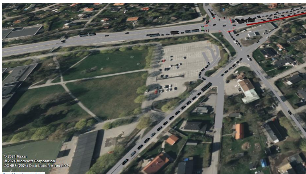
Figur 7: Långa köer på Gymnasievägen i scenario 1. Blockerar utfart från parkering och Norrgårdsvägen
