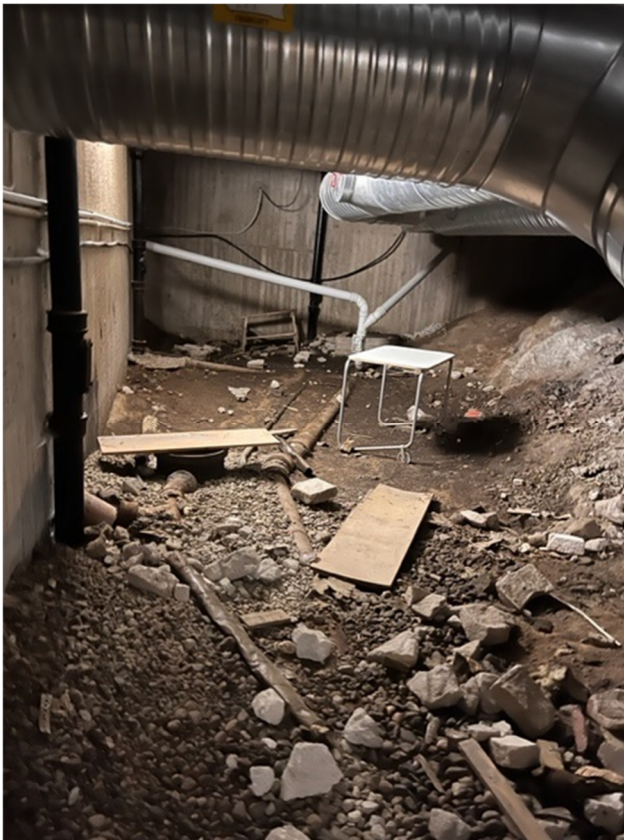
Figur 9. Brickan 8, foto under hus. Foto taget 2023-09-05 av Anders Melin, Hus F.
