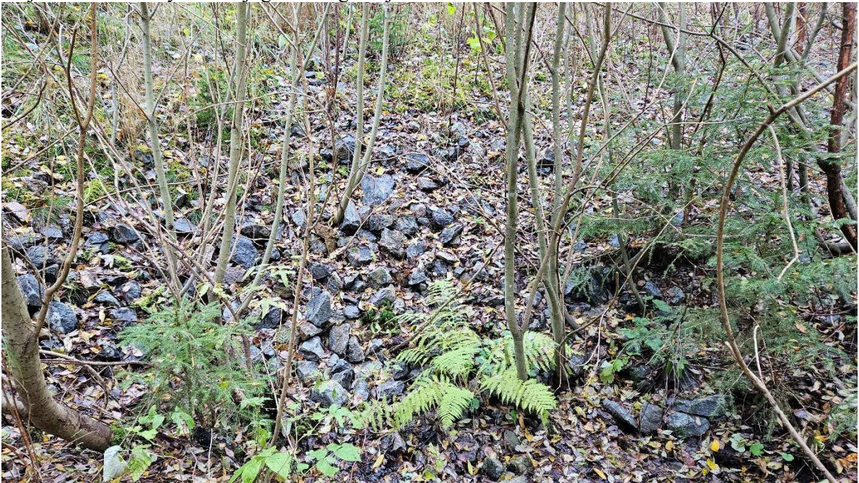
Figur 6. Upplagda stenar i en slänt över en trumma.
