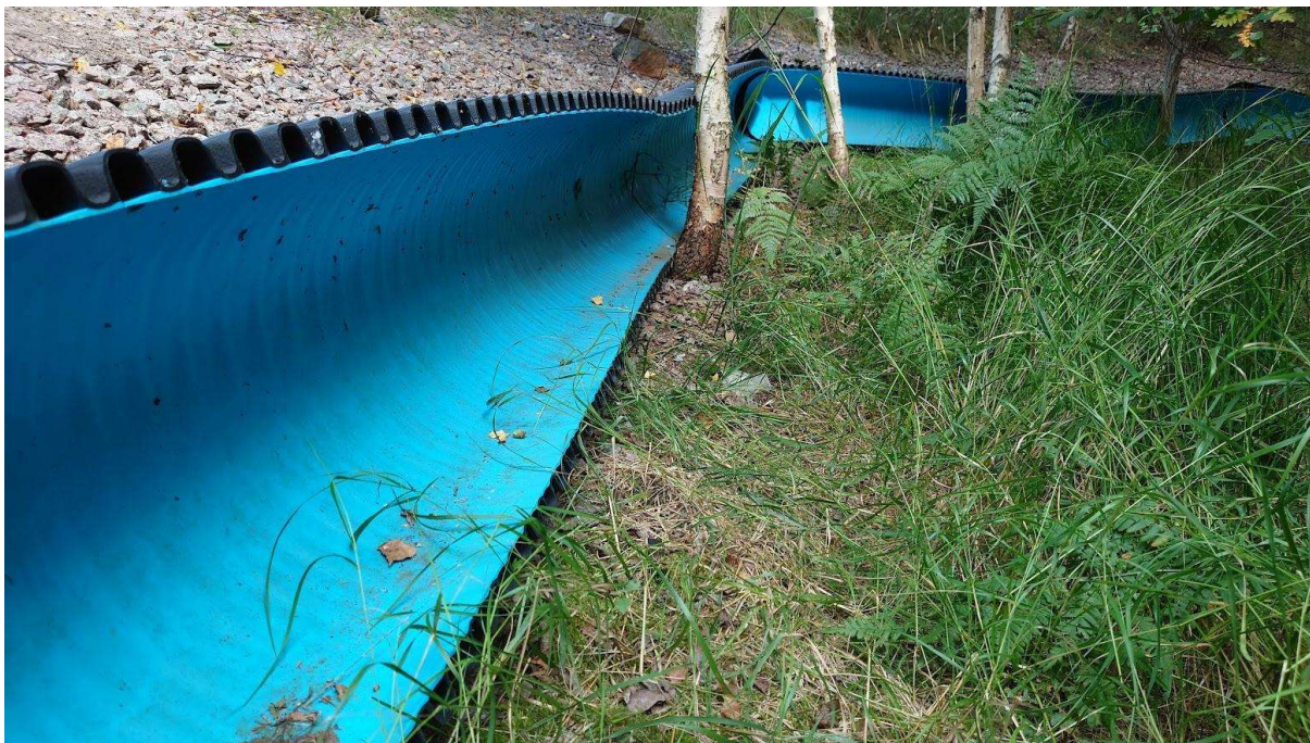
Figur 12: Exempel på s.k. ledarmar som leder groddjuren in i passagerna och hindrar dem från att gå upp på vägen. Ledarmar i betong är att föredra. Bilden tagen av Sara Lundkvist, Naturföretaget.
