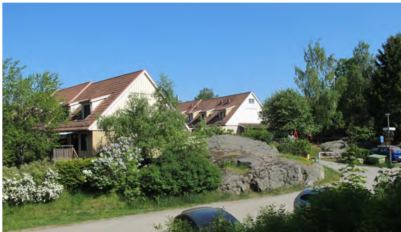
Exempel på befintlig bebyggelse där stor hänsyn har tagits till omgivande terräng genom att byggnader har anpassats till denna samt bevarandet av befintlig natur. Källa: Kulturmiljöprogram 2019, s.159.
