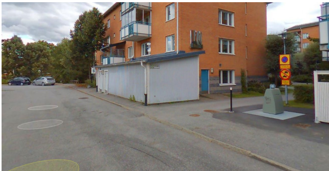
Figur 2. Visar miljöhuset vid kvarteret Koljan. Den bottentömmande behållaren syns till höger om infartsvägen till bostäderna. Bildkälla: Eniro
